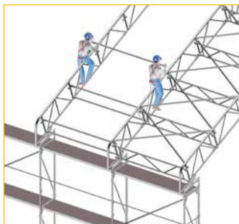
► Collegamento delle campate successive
